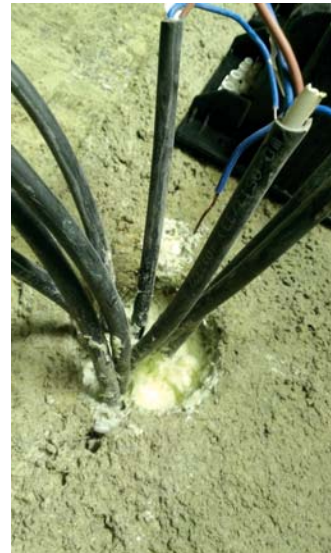
Kablo veya boru geçişi KÖSTER KB-Flex 200 kalıcı elastik macun ile doldurulur.
