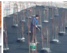
Fore kazıklı temel yalıtımında KÖSTER Deuxan 2K uygulaması
