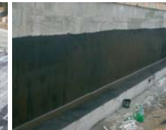
Perde duvar yalıtımında KÖSTER Deuxan 2K uygulaması
