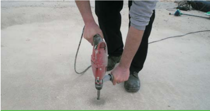
Uygulama delikleri matkap yardımıyla açılır.
