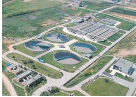
İSKİ Paşaköy Arıtma Tesisi, İstanbul
