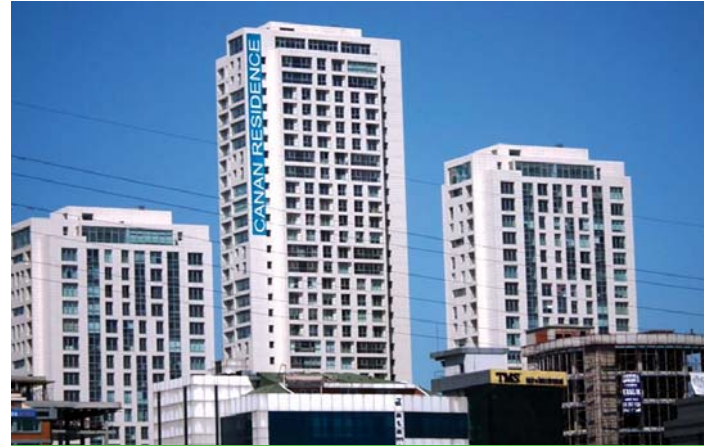
İstanbul Canan Residence'da KÖSTER Latex kullanılmıştır.
