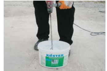
Bond Paste bileşenleri motorlu karıştırıcı ile homojen kıvamda karıştırılır.
