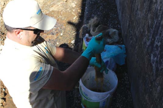
KÖSTER KB-Pur GEL hazırlanması
