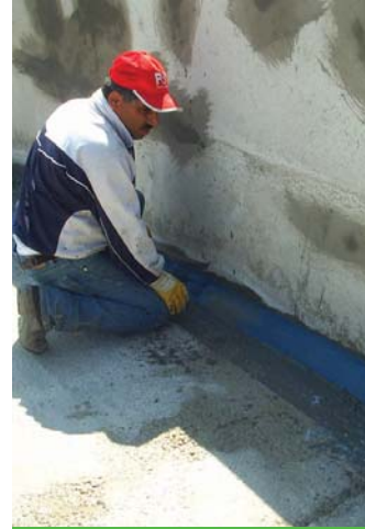
Köşe pahlarının oluşturulmasında ve tij deliklerinin doldurulmasında KÖSTER Repamor kullanılır.
