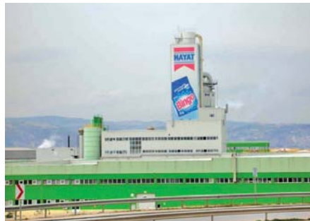
Hayat Kimya Fabrikası, Kocaeli
