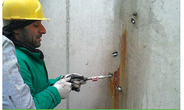
Betonarme perde duvarlara enjeksiyon uygulaması
