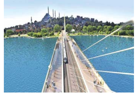
Haliç Metro Köprüsü, İstanbul
