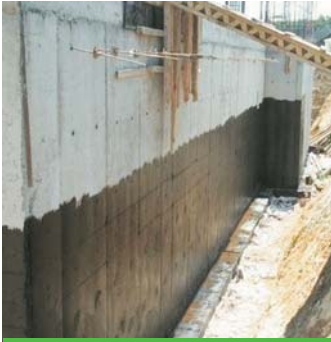
Perde duvar uygulaması
