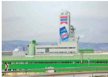
Hayat Kimya Fabrikası, Kocaeli
