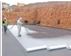
Püskürtme ekipmanı ile KÖSTER Deuxan 2K uygulaması
