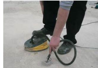
Delikler basınçlı hava ve fırça ile toz ve gevşek parçacıklardan arındırılır.
