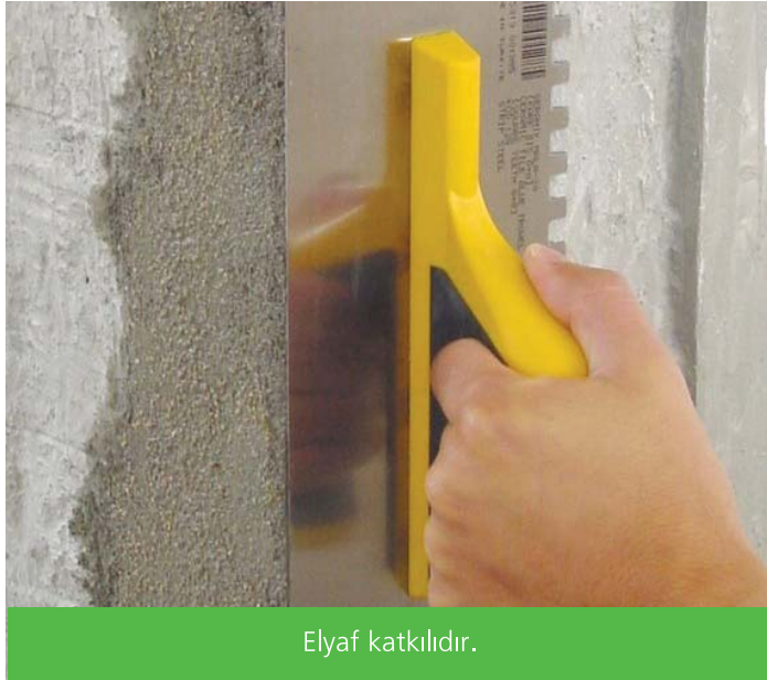
Köşe pahlarının oluşturulmasında ve tij deliklerinin doldurulmasında KÖSTER Repamor kullanılır.
