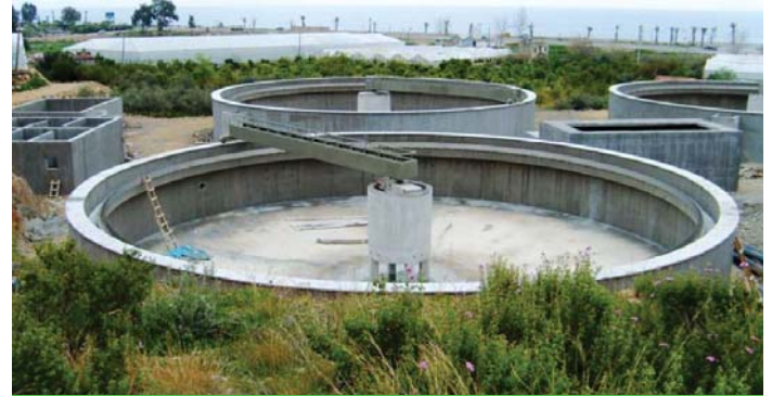
Alanya Konaklı Belediyesi Arıtma Tesisi'nde KÖSTER NB Super Kullanılmıştır.
