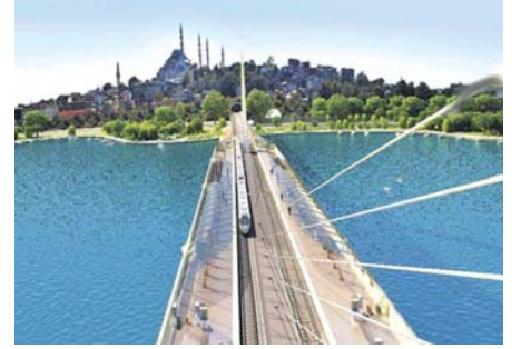
Haliç Metro Köprüsü, İstanbul
