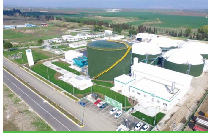
Bursa Süttaş Arıtma Tesisi'nde KÖSTER Yıldırım Tozu kullanılmıştır.
