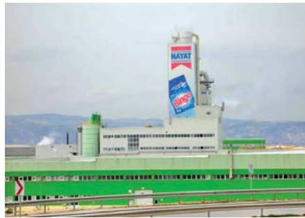
Hayat Kimya Fabrikası, Kocaeli
