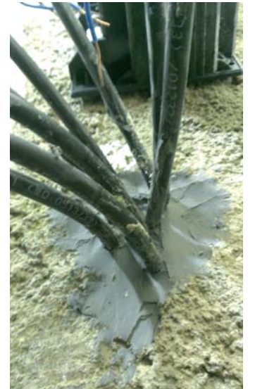
Kablo veya boru geçişi KÖSTER KB-Flex 200 kalıcı elastik macun ile doldurulur.
