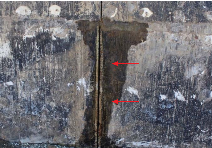
KÖSTER KB-Pur GEL uygulanacak derz görüntüsü
