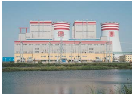
Harbin Elektrik Santrali, Çin
